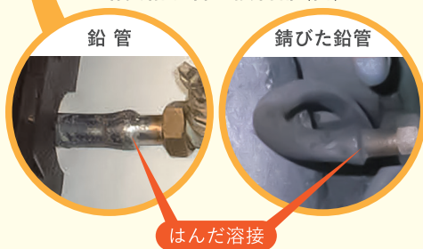
鉛製給水管の接合部(例)
